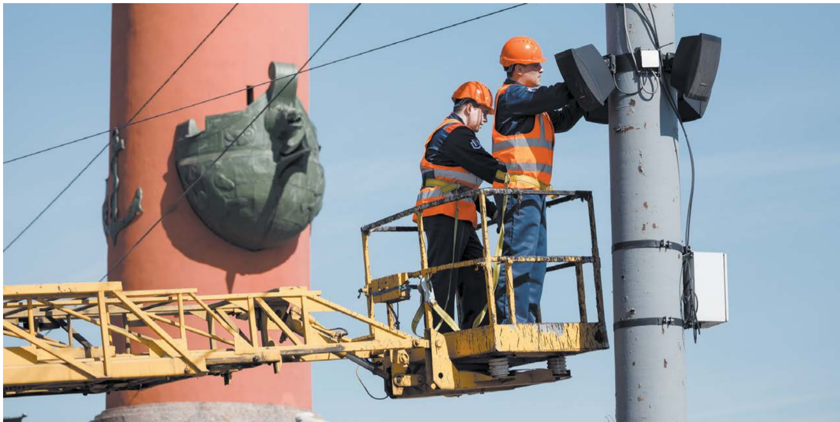
Монтаж smart-системы на Стрелке Васильевского острова | ПРЕДОСТАВЛЕНО КОМИТЕТОМ ПО ИНФОРМАТИЗАЦИИ И СВЯЗИ
