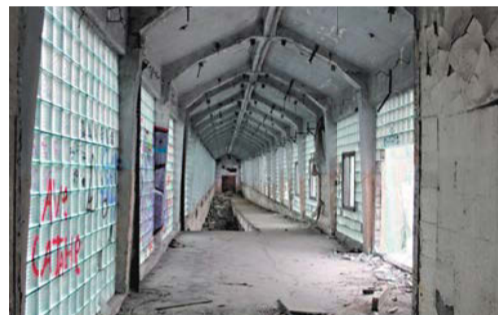
В некоторых корпусах завода сохранилось раритетное оконное остекление
