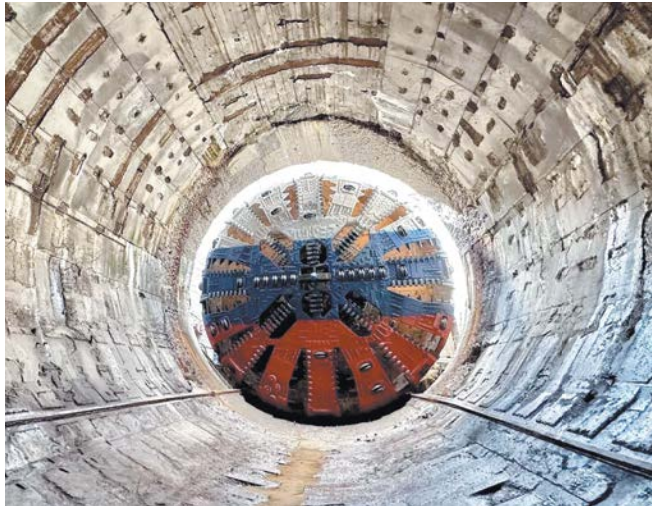
Щит «Надежда» начал движение в сторону новой станции метро «Яхтенная» | ПРЕСС-СЛУЖБА ГУБЕРНАТОРА
