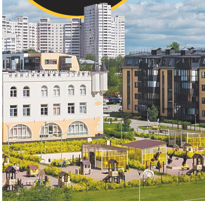
Грамотно сформированная среда, так называемая пассивная безопасность, становится залогом комфортной жизни | ГК «ЛЕНСТРОЙТРЕСТ»
