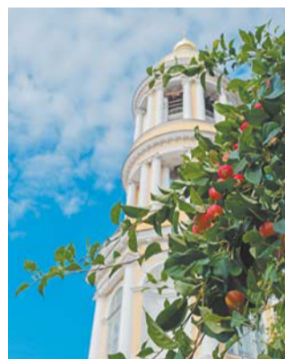
Колокольня Владимирского собора
