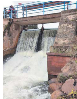
Весной на плотине Сиверской ГЭС разливается вода бурным потоком
