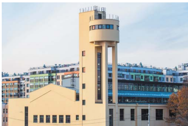
Канатный цех с водонапорной башней завода «Красный гвоздильщик» был построен в 1931 году по проекту Якова Чернихова | METRO
