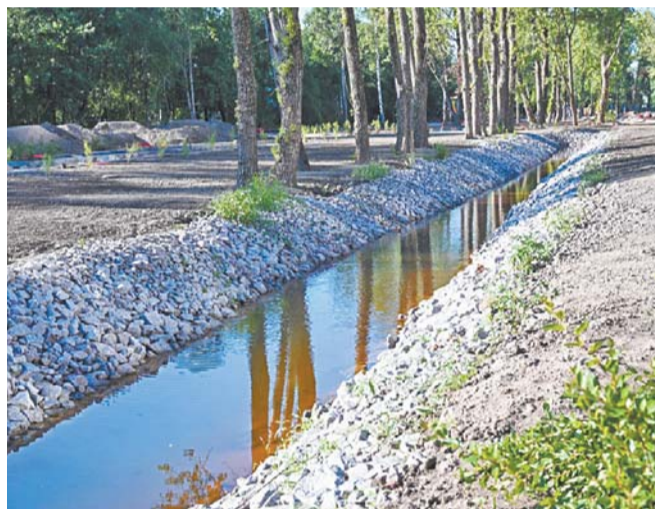
В новом сквере кипят работы по благоустройству | ИГОРЬ АКИМОВ
