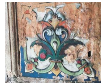
Цветная плитка, скрытая под слоем штукатурки, до реставрации | КГИОП
