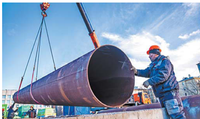
Идёт реконструкция тепломагистрали | GOV.SPb.RU
