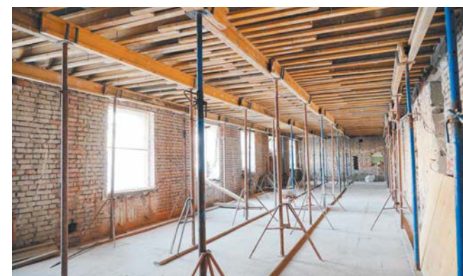
Работы внутри идут уже полным ходом | ВСЕ ФОТО: ОФИЦИАЛЬНЫЙ ТЕЛЕГРАМ-КАНАЛ АЛЕКСАНДРА БЕГЛОВА T.ME@A_BEGLOV
