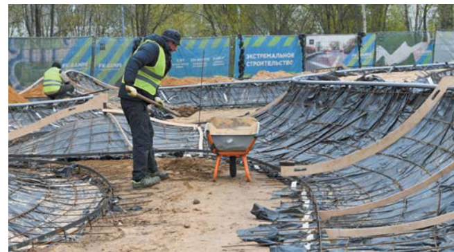
Новое оборудование с бетонным покрытием уже ждёт установки | ИГОРЬ АКИМОВ
