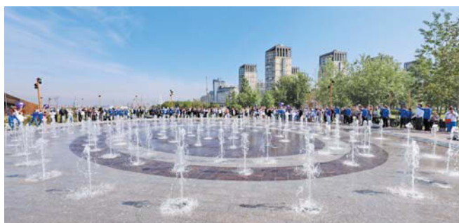
Чаша нового фонтана имеет форму овала с размерами 32,8 метра на 24,8 метра. Максимальная высота струй – 9 метров. Световые эффекты обеспечивают более 200 подводных светодиодных светильников | GOV.SPB.RU
