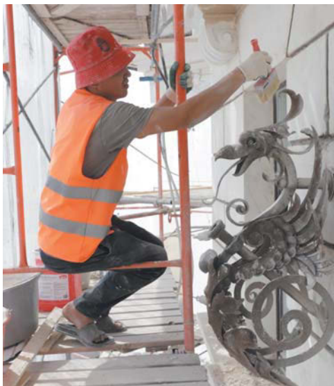
В августе с бывшего доходного дома снимут строительные леса | ФОТО: ИГОРЬ АКИМОВ, ФОНД КАПИТАЛЬНОГО РЕМОНТА
