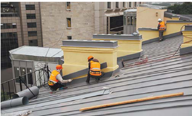
Отремонтированные кровли надёжно защищают от протечек | GOV.SPB.RU
