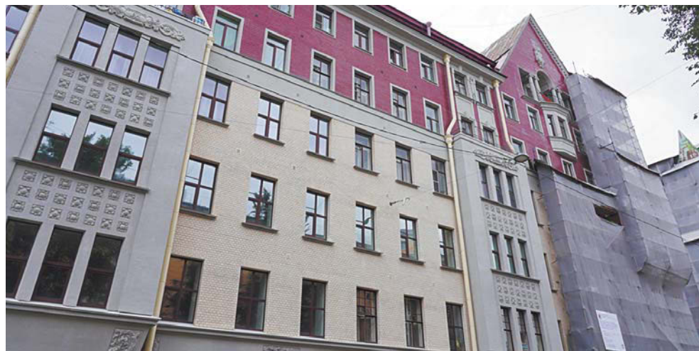
В отделе использованы разноцветные керамические плитки светло-кремового оттенка в нижних частях здания и цвета бургунди – в верхних | ВСЕ ФОТО: GOV.SPB.RU
